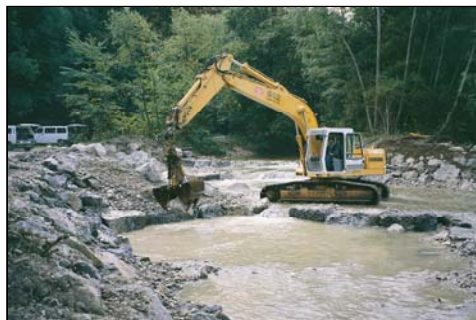
Konstruksjon av nytt elveløp. Foto: T. Østdahl.
